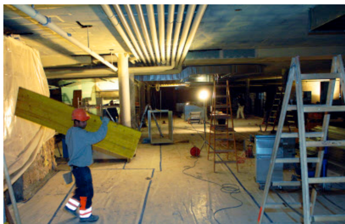
Die Unterführung bekommt neue Haustechnik.
