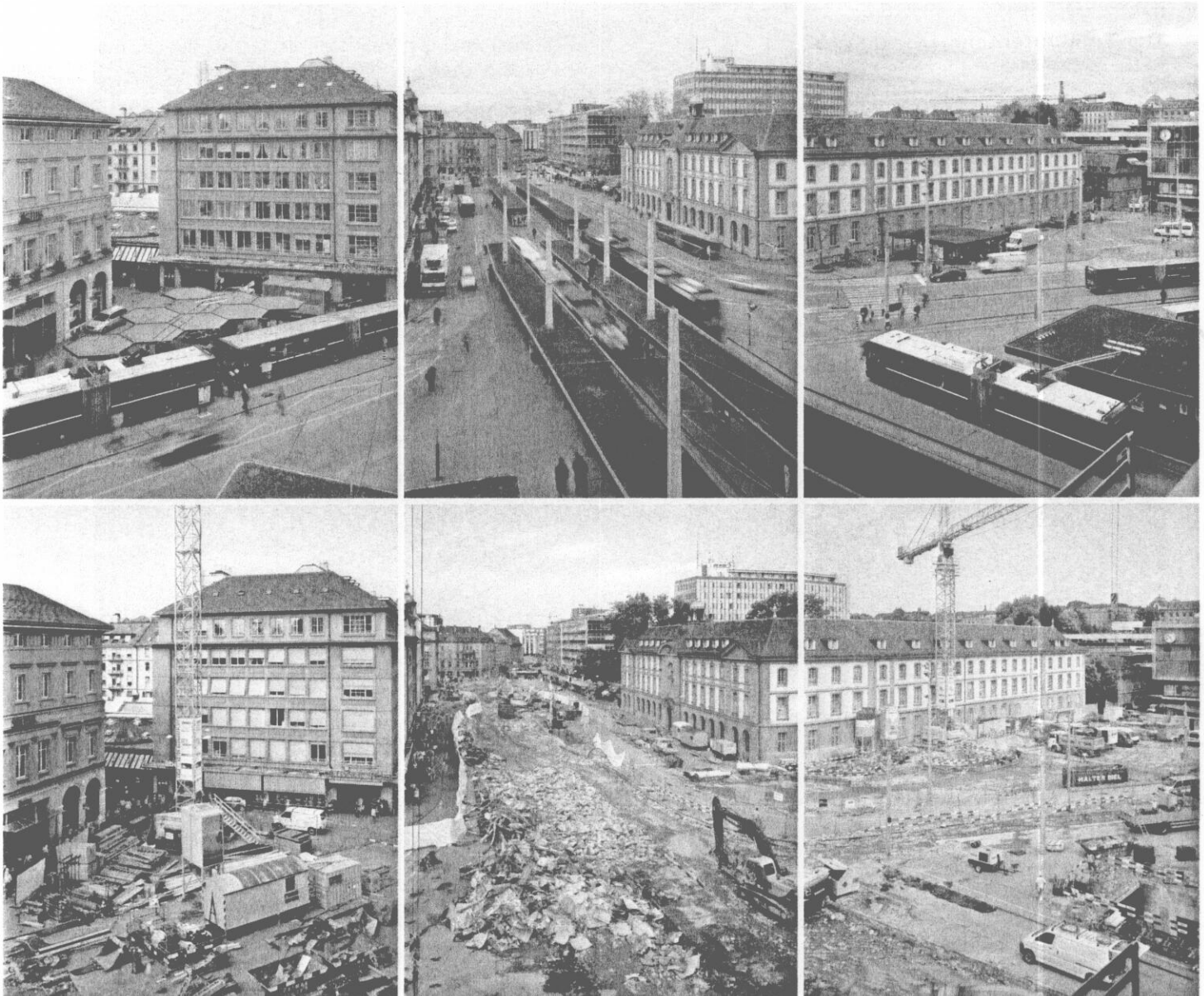
2: Der Bahnhofplatz Bern vor und während des Umbaus.
